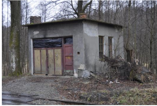
Fot. 28. SUSZARNIA PIASKU w Jaworniku-Przedmieście kolejki wąskotorowej Przeworsk-Dynów, 1902/1984 r.
