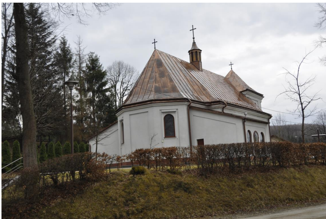
Fot. 1-2. CERKIEW GR.-KAT. FILIALNA P.W. PRZEMIENIENIA PAŃSKIEGO ob. kościół rzym.-kat. par. p.w. Niepokalanego Serca NMP, 1792 r.
